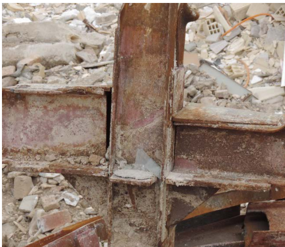
شکل (۱-۲): نمونه‌ای از آسیب‌های ایجاد شده در اتصالات سامانه‌ی باربر قاب خمشی در یک ساختمان فولادی
